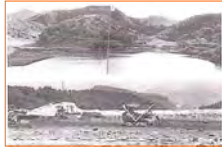
湯浅農場の造成工事
